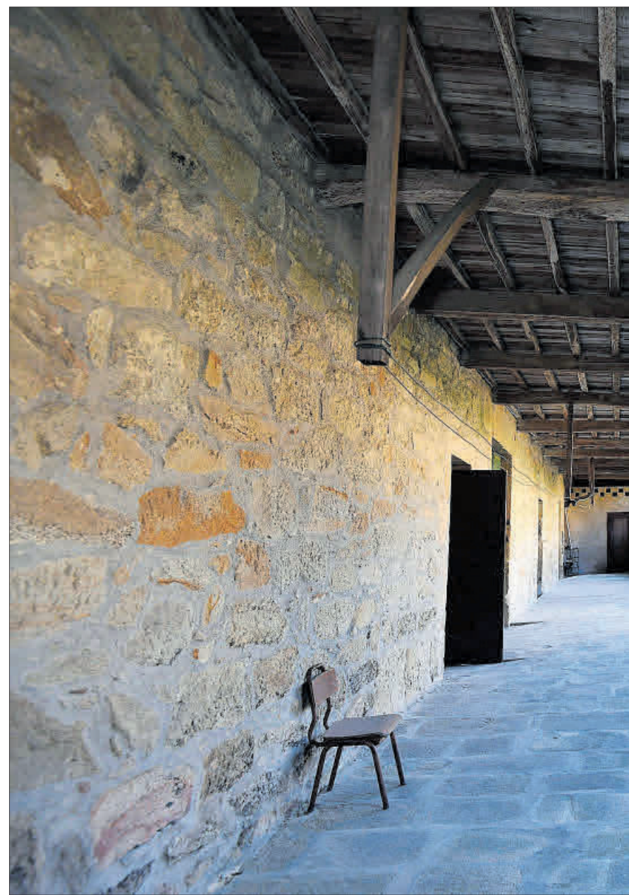
Uno de los laterales del claustro, que está cerrado por dos lados y que data del
